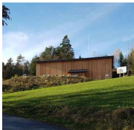
Hochbehälter Stein, Gde. Altenfelden
