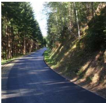
Sanierung GW Kirchholz 2015
