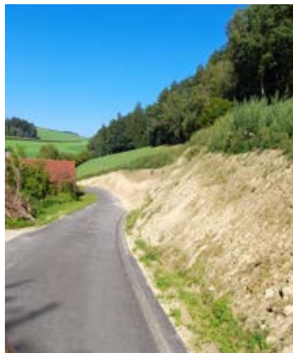
GW Asanger vom WEV fertiggestellt
