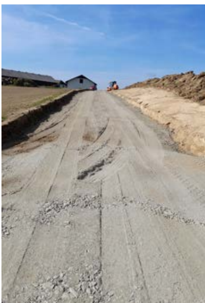
Generalsanierung der Gemeindestraße Eiglersdorf-Furthkreuz
