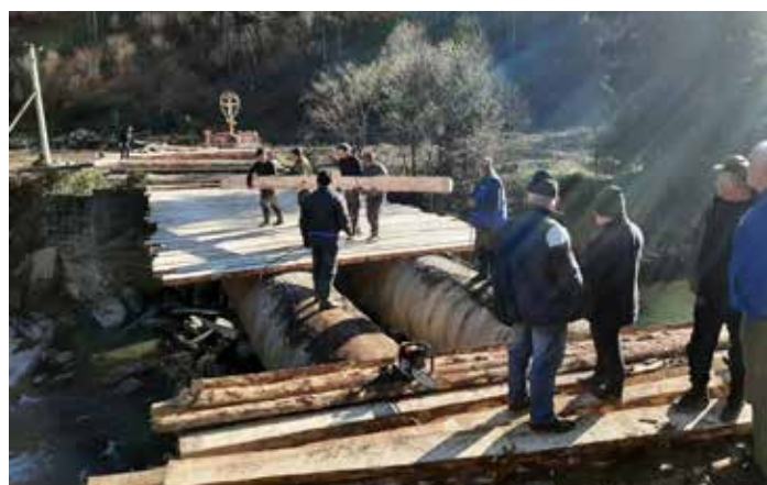
Brückenbau im Teresiental
