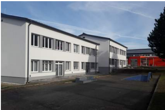
Nach 3 Jahren Sanierung: eine topmoderne Volksschule! 2019 kommt als 4. Bauetappe noch die Außengestaltung.
