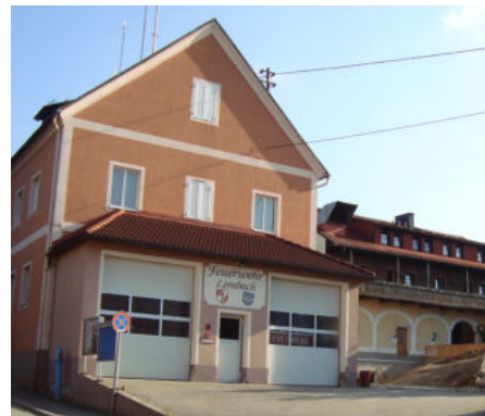
Vergrößerung der Feuerwehrgaragen für neues TLF-Fahrzeug und neue pelle mit elektrische Tore
