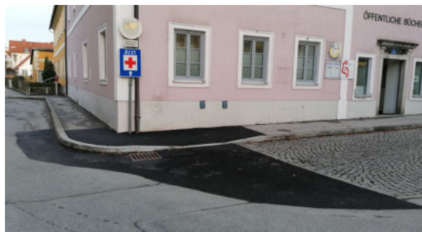
Und fertig ist der neue, abgeflachte Gehsteig im Ortsinneren.
