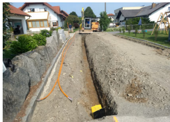
Im Zuge der Asphaltierung eines Teilstückes der Moritz-Scheiblstraße wurden unter Zugrundelegung eines Verlegeplanes die für den späteren Vollausbau mit Glasfaser passenden Leerrohre zu jedem Wohnobjekt verlegt. Foto:LN
