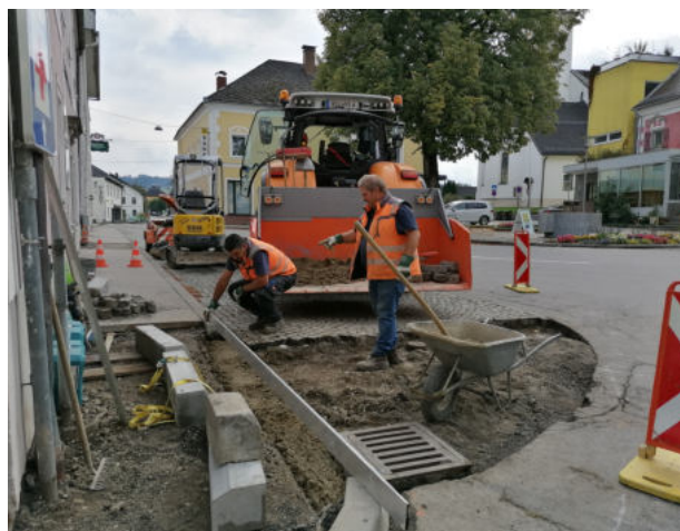
Unsere Bauhofmitarbeiter Helmut und Berthold bei der Abflachung des Gehsteigs.
