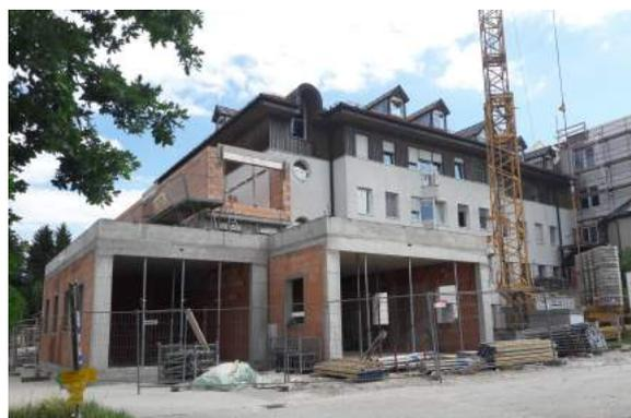
Im Zuge der Altenheimsanierung setzt auch das Rote Kreuz Baumaßnahmen um: Die Garagen wurden erhöht und eine Waschbox angebaut, weil der Reinlichkeit von Rettungautos sehr große Bedeutung zukommt.
