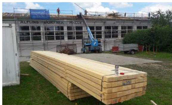
Die Schneedruck-Katastrophe von 2006 führte zu neuen Normen in der Statik von Dächern. Daher müssen auch die Dachstühle der VS und ADH normgemäß verstärkt werden. Statt dem Welleternit werden Gleitbügeldächer aus Metall montiert.
