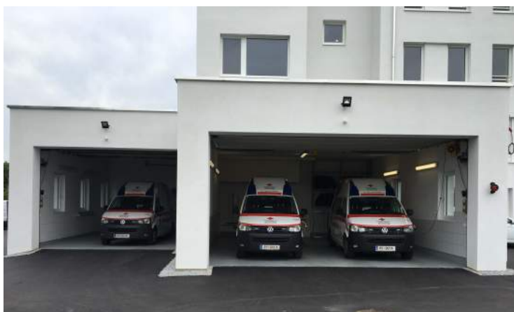
Die Ansicht auf die neue Garage und Waschbox
