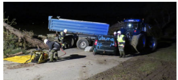
Vorbereitung der Einsatzgeräte
