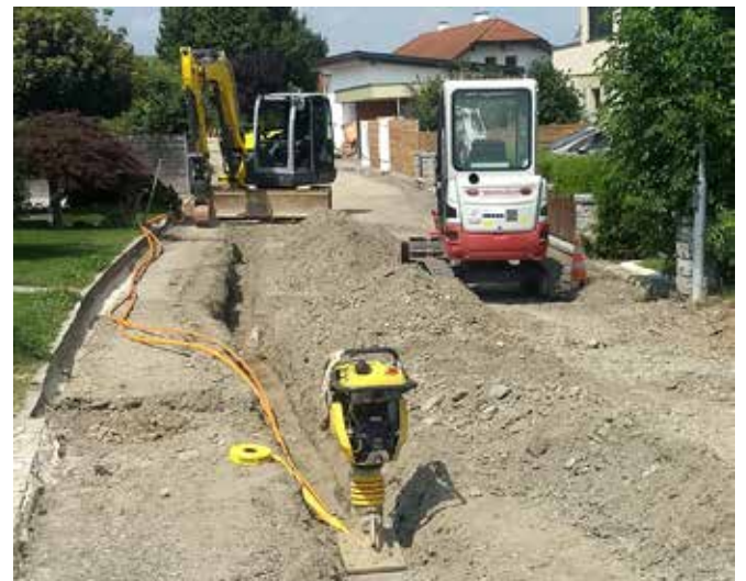
Zur Leerrohrverlegung ist der Aushub solcher Gräben notwendig.
