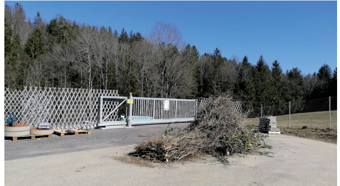
Der neue öffentliche Strauchschnittlagerplatz in der Kläranlage (Teichweg)
