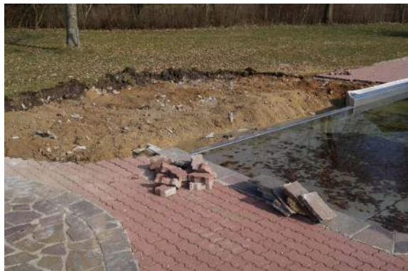
Der bei Kleinkindern zwar beliebte, aber undichte und immer reparaturbedürftige Strandbereich wurde entfernt. Das Edelstahlbecken wird mit einer Überlaufrinne geschlossen.
