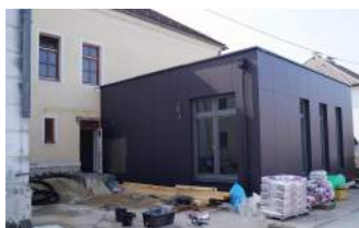
Der moderne, schalldichte Schlagwerkraum hebt sich gut von der historischen Bausubstanz der ehemaligen Volksschule aus 1906 ab. Beim alten Gebäude sind außen und innen im Bereich Sitzungssaal und Trauungsraum über dem Fußbodenniveau Putzsanierungsarbeiten gegen die Feuchtigkeit notwendig.
