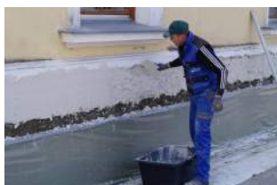
Der moderne, schalldichte Schlagwerkraum hebt sich gut von der historischen Bausubstanz der ehemaligen Volksschule aus 1906 ab. Beim alten Gebäude sind außen und innen im Bereich Sitzungssaal und Trauungsraum über dem Fußbodenniveau Putzsanierungsarbeiten gegen die Feuchtigkeit notwendig.
