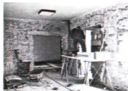
Baustelle: Zahnarztordination im alten Pfarrheim
