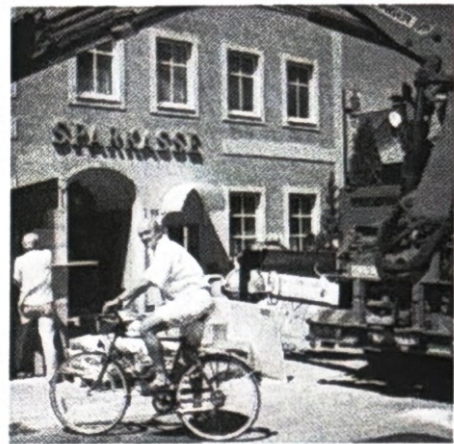
Bgm. Herbert Kumpfmüller überzeugt sich vom Fortschritt der Umbauarbeiten
