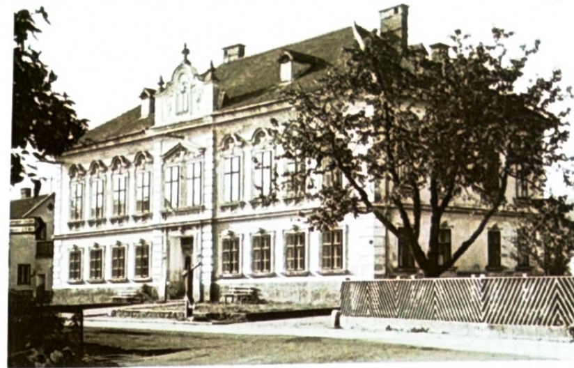
Das alte Volks- und Hauptschulgebäude. Heute Marktgemeindeamt und Musikschule. Quelle: Gemeindechronik
